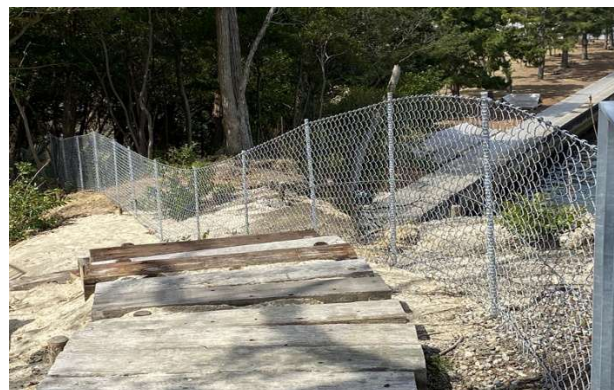
夕日が見える展望台撤去、フェンス新設
