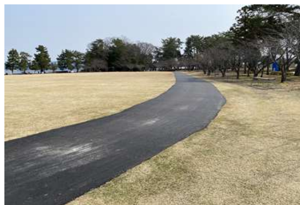
緑地外周舗装工事
