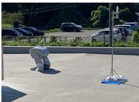
和倉温泉お祭り会館屋上
